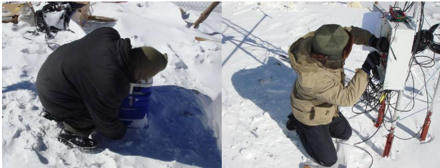
图 f-5 建设中的大冬树山垭口积雪观测站
