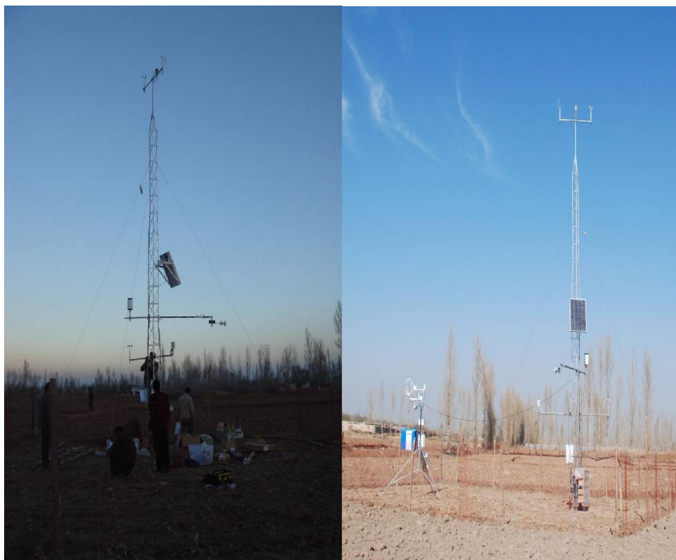
图 b-4 建设中的盈科灌区绿洲站（左），建成后的盈科灌区绿洲站（右）
