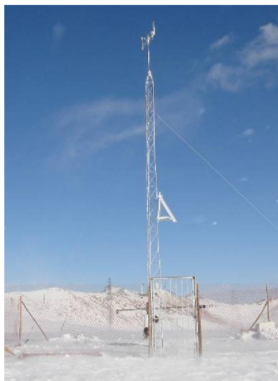
图 f-2 高 10m 的微气象观测塔
