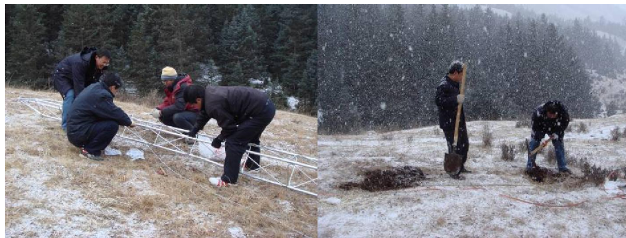
图 d-3 建设中的大野口马莲滩草地站
